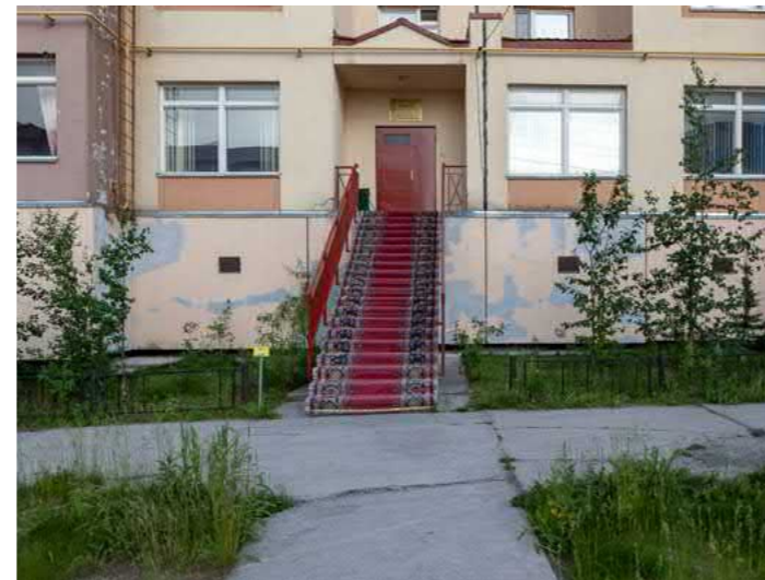
Устройство крылец высотой более 1,2 м от уровня земли
