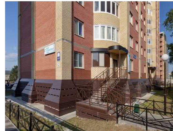
Громоздкие и неудобные конструкции крылец
