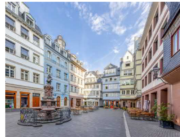
г. Франкфурт-на-Майне, Германия Реновация района старого города: формирование преемственности пространственной среды путём сохранения исторического облика района
