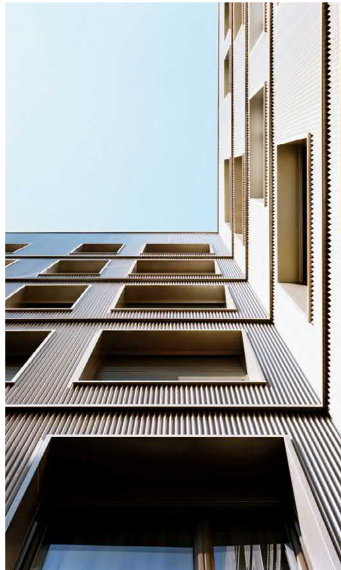
г. Париж, Франция Использование навесных систем фасадов для формирования узнаваемого облика зданий
