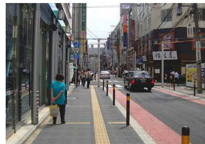
Использование технических решений для создания комфортных условий передвижения маломобильных групп населения и инвалидов
