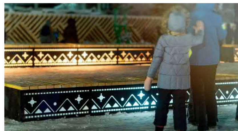
↑ Площадь «Колымское подворье» в Среднеколымске -освещение мест кратковременного отдыха на подпорных стенках (освещение подиумов)
